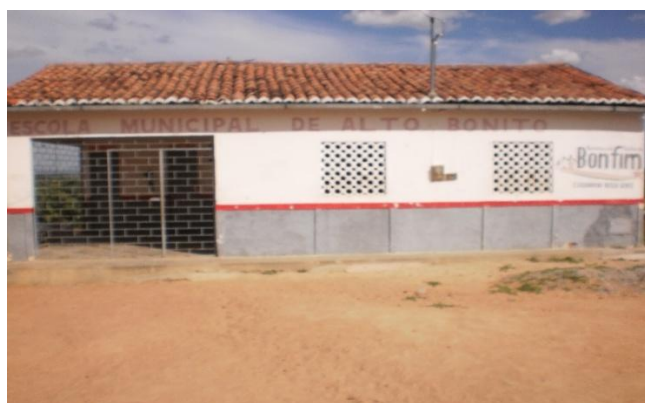
Figura 02 – Imagem frontal da Escola Municipal de Alto Bonito.
