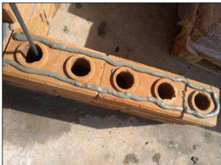
Figura 2: detalhe do assentamento dos tijolos.
