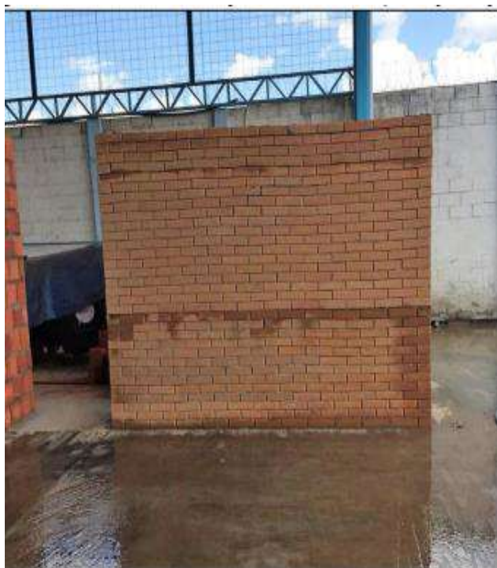
Figura 1: parede de testes.
