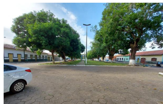
Figura 6: Vista 2 Inferior Externa Fonte: Prefeitura de Carolina (2021)
