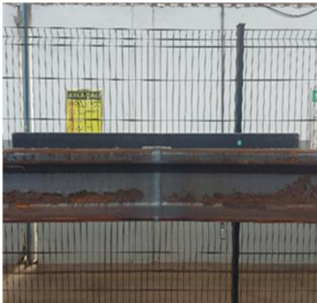
Figura 20 - Procedimento atual para inspeção do desalinhamento vertical.
