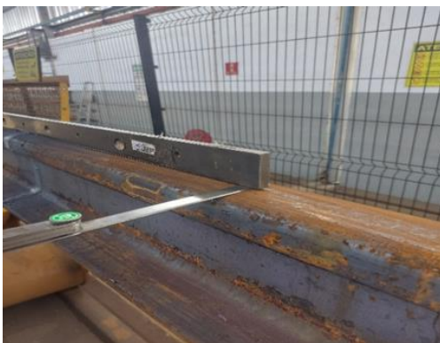
Figura 6 – Inspeção Geométrica pós soldagem do desalinhamento vertical, utilizando o calibre canivete para a conferência da tolerância aceitável.
