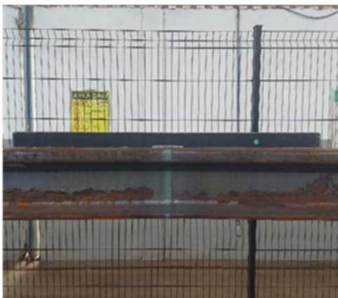
Figura 5 – Inspeção Geométrica pós soldagem do desalinhamento vertical (flecha).
