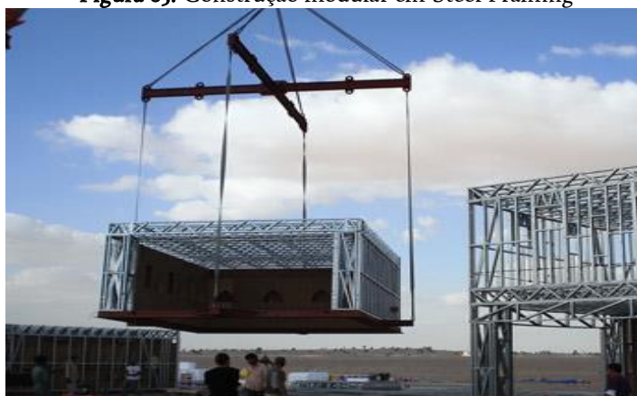
Figura 03: Construção modular em Steel Framing
