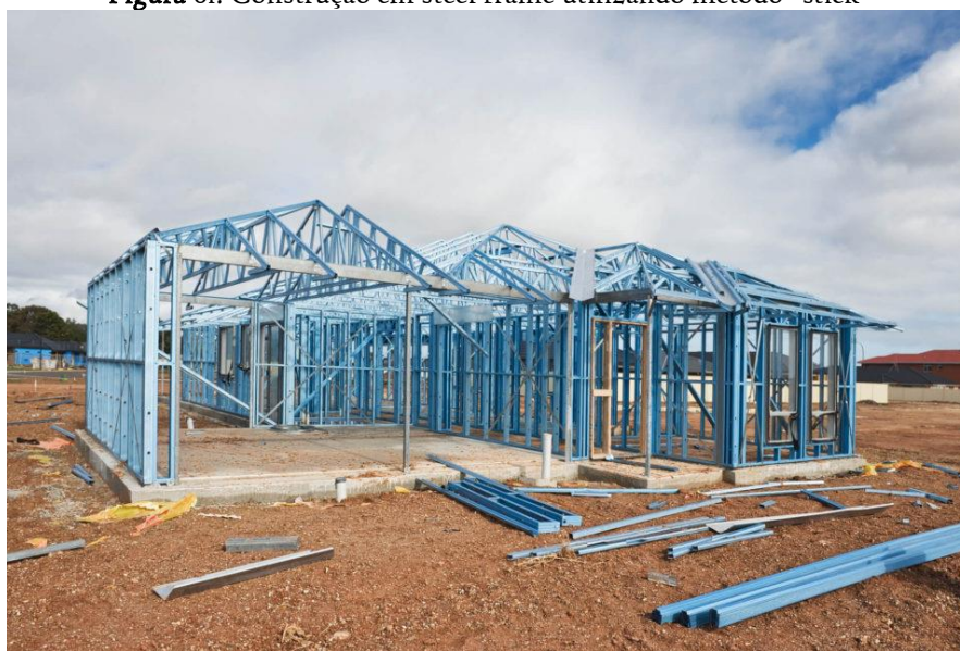
Figura 01: Construção em steel frame utilizando método “stick”
