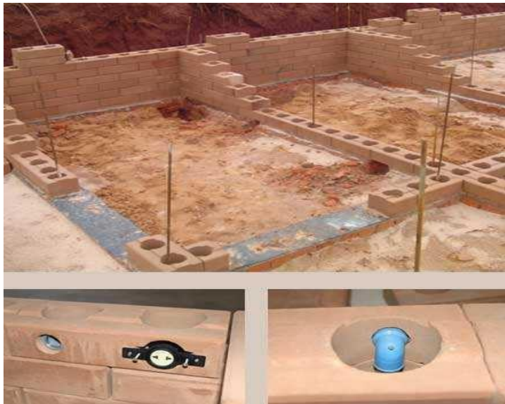
Figura 17: Sistema Construtivo Tijolo Ecológico Fonte: www.construvan.com.br
