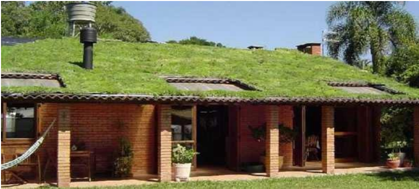
Figura 20: Aplicação da ecotelha na cobertura de uma Residência.
