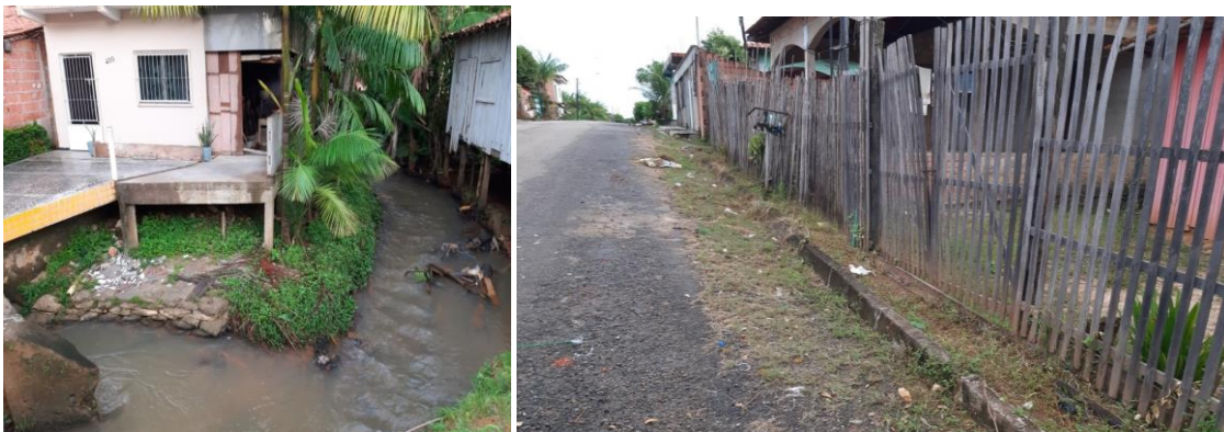
Figura 4 – Edificação ao lado do igarapé e sistema viário inadequado.
