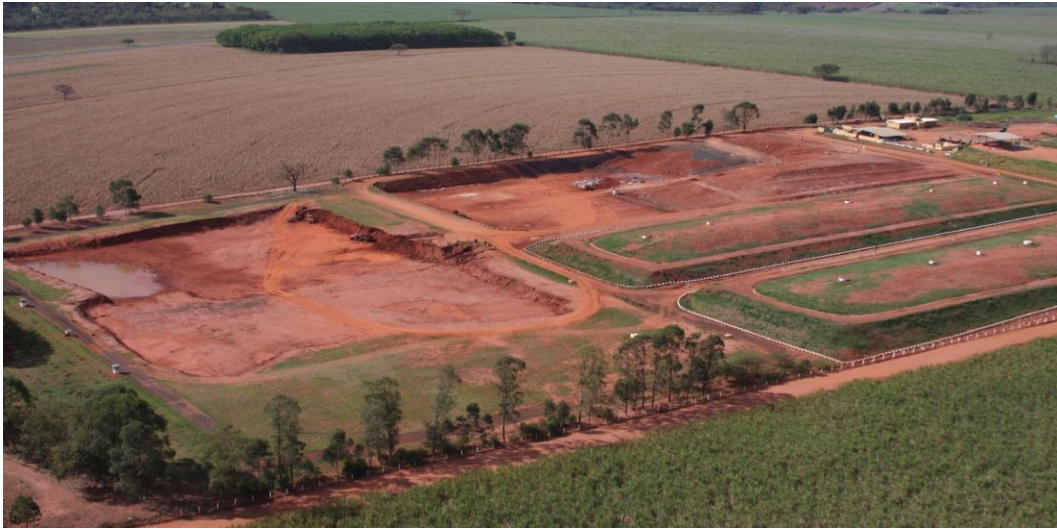
Imagem 2: imagens de uma célula aberta, faltando somente a impermeabilização do solo com a Manta PEAD (Fonte: Gestão de Resíduo Online)
