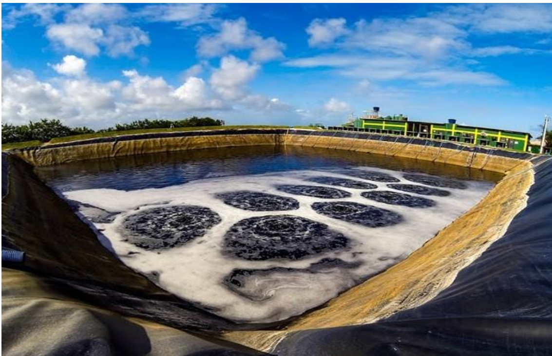
Imagem 7: imagem de uma lagoa de tratamento de chorume em processo de decantação (Fonte: Sustentável.com.br)
