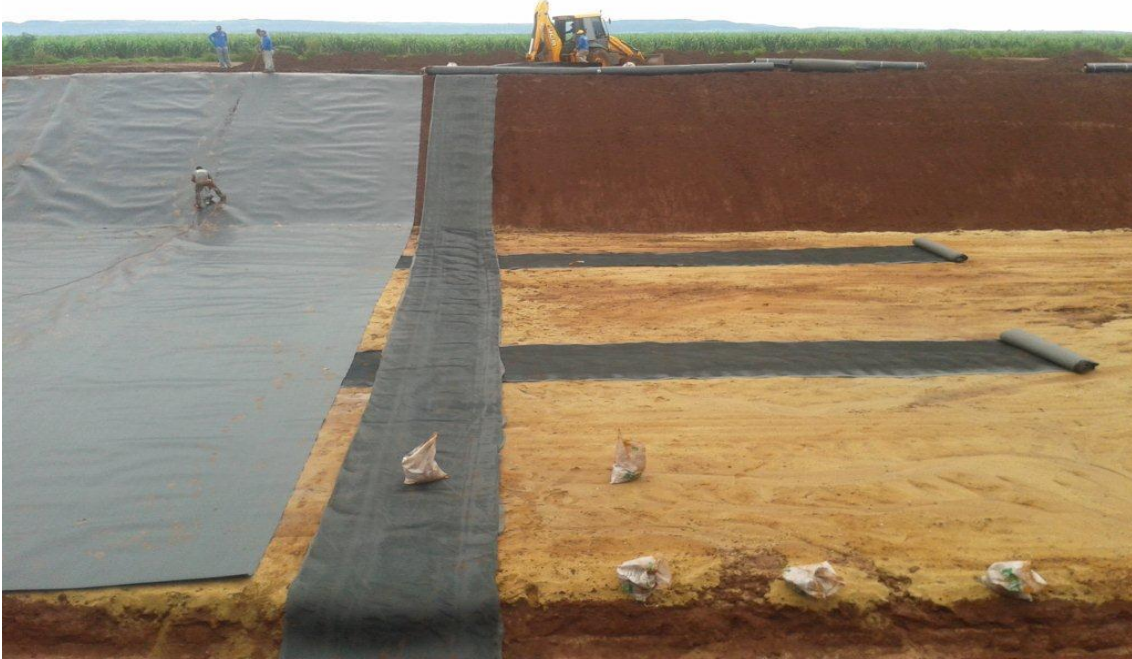
Imagem 4: imagem de um solo tratado com bentonita com a camada de 30 cm de fundo já pronta (Fonte: http://www.manta.eng.br/ )
