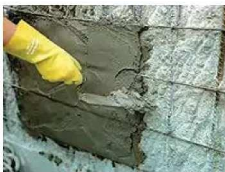
Figura 5 - Aplicação de Argamassa no reparo estrutural
