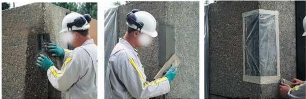
Figura 6 - Aplicação de graute sobre uma estrutura de concreto
