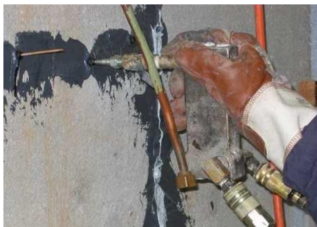
Figura 8 - Reparação de fissura pela injeção de resina epoxidica sob pressão
