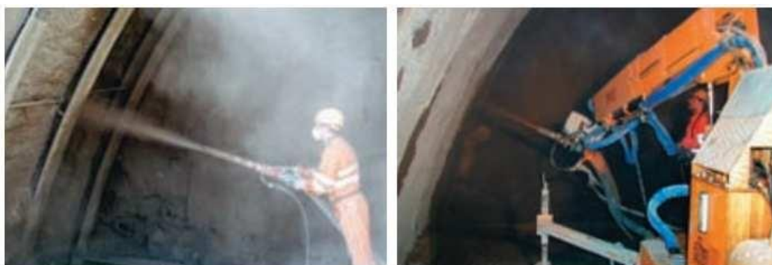
Figura 7 - Aplicação do spray de concreto por via seca (1) e via úmida (2)
