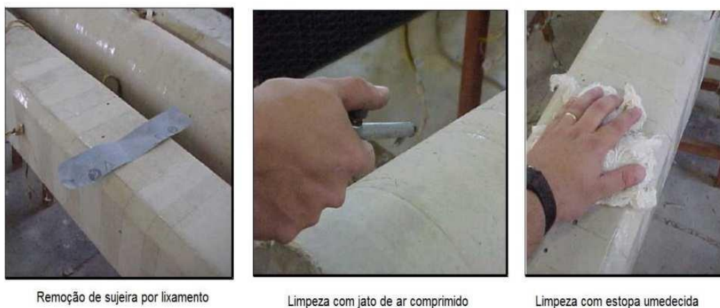
Figura 9 - Etapas de limpeza da superfície de concreto
