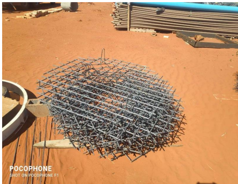
Ferragens para fazer a armação do Poço de Visita (PV).
