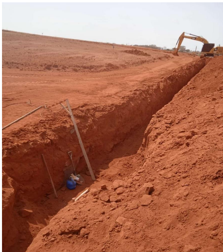
Abertura de Vala para instalação da Rede Coletora de Esgoto no Terço Carroçável.
