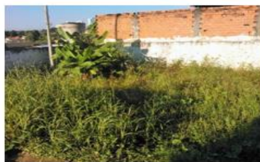
Foto 5 – Terreno ao redor das salas
