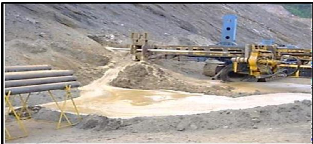
Figura 4 - Perfuratriz realizando um DHP, com limpeza de furo.
