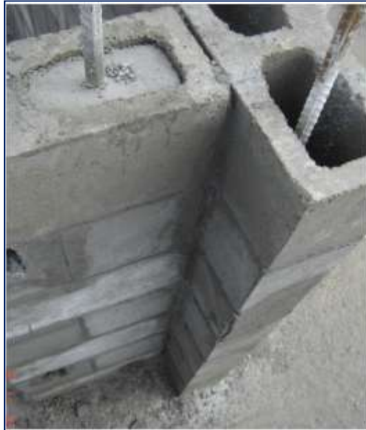
Figura 14 – Exemplo de Grauteamento
