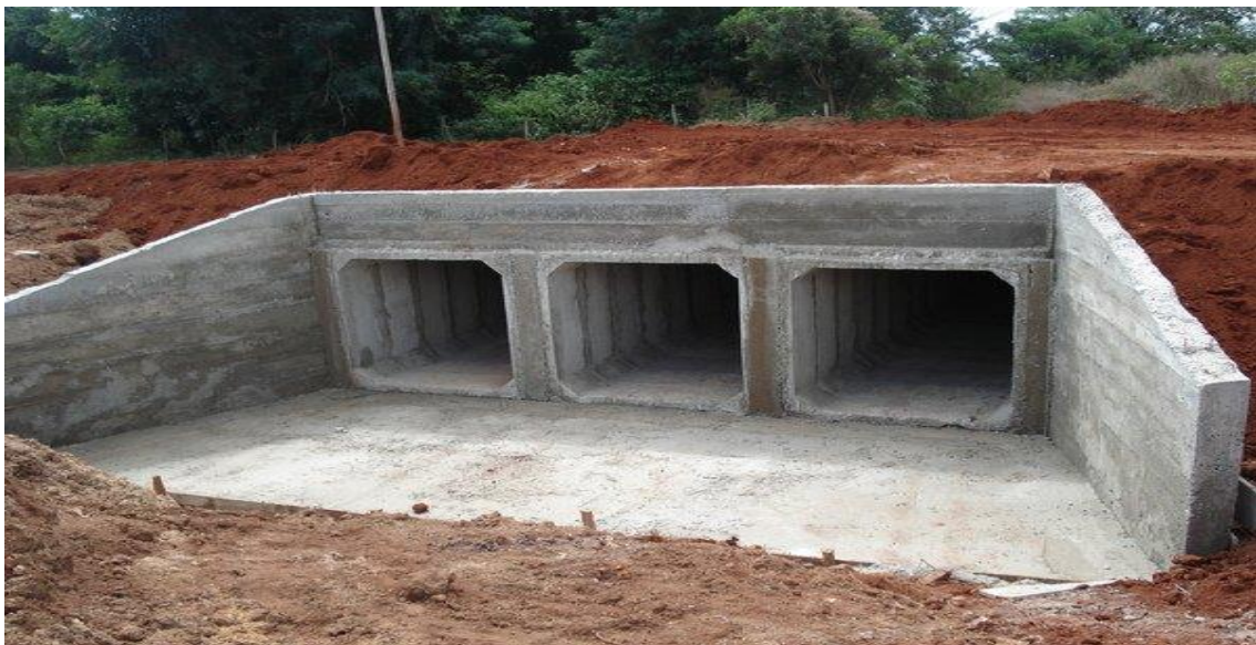
Imagem 22. Bueiro celular de concreto
