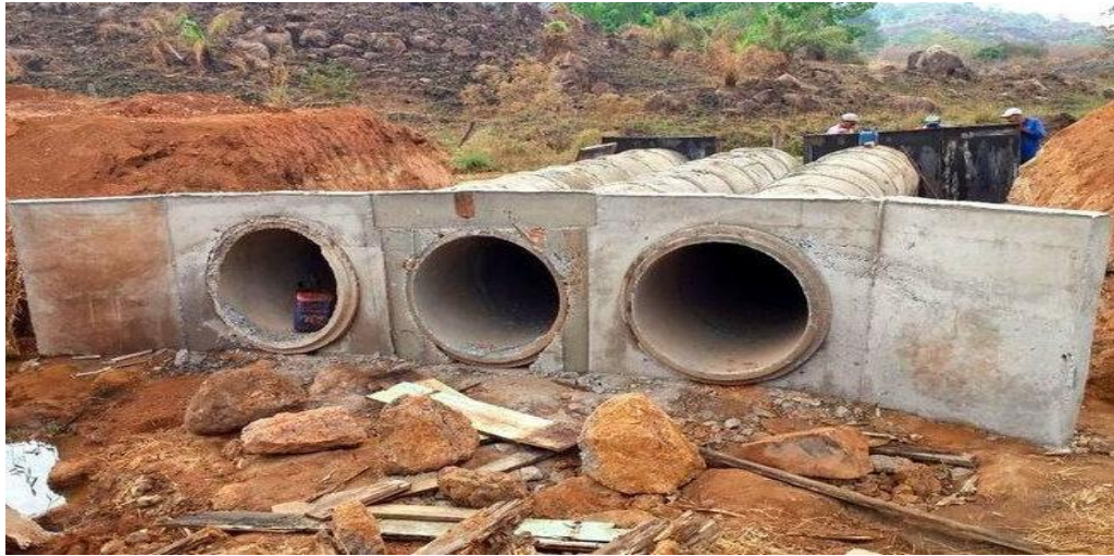
Imagem 21. Bueiro triplo tubular de concreto
