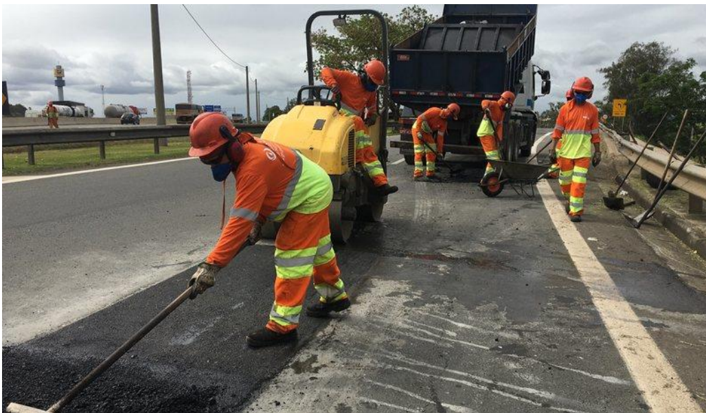
Imagem 1. Manutenção e conservação da rodovia
