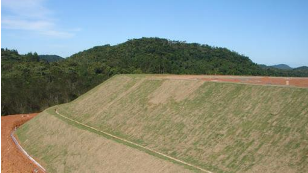
Imagem 2. Valeta de proteção de aterro
