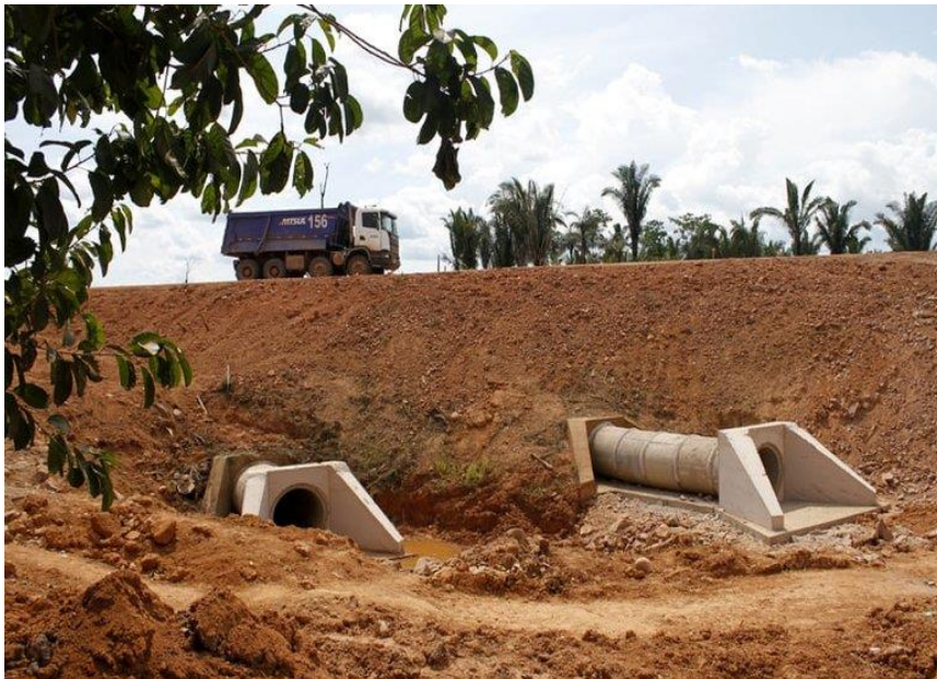
Imagem 6. Bueiro de greide de concreto
