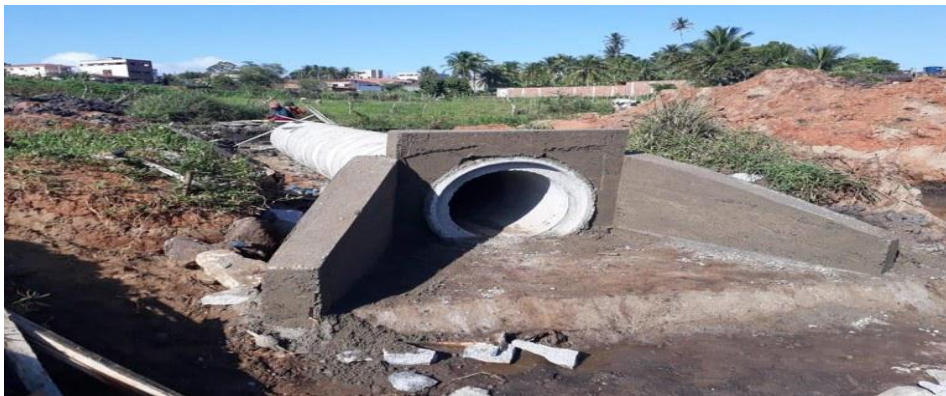
Imagem 19. Bueiro simples tubular de concreto
