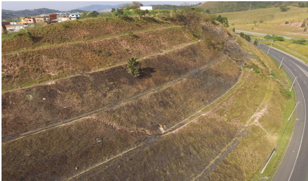
Imagem 9. Escalonamento do talude frontal
