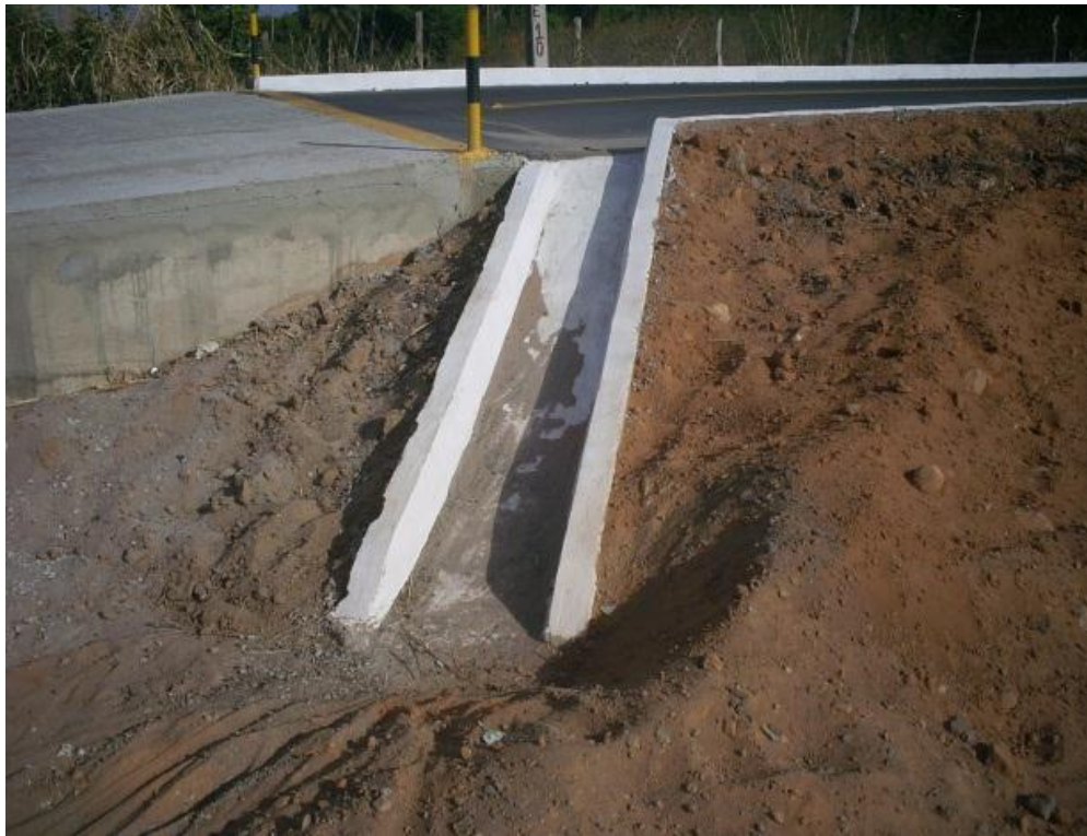
Imagem 4. Sarjeta de aterro
