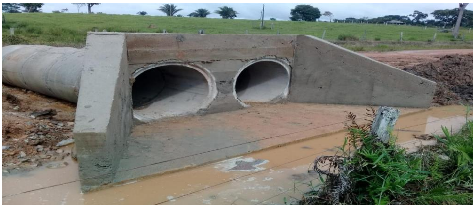
Imagem 20. Bueiro duplo tubular de concreto
