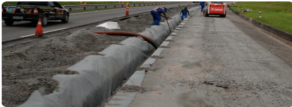
Imagem 25. Dreno subsuperficial de base
