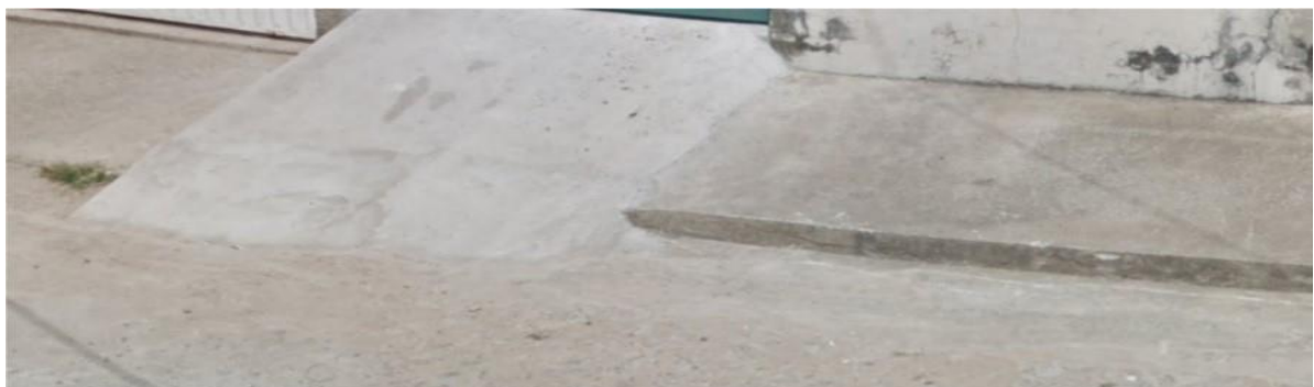
Figura 8: Modificações feitas na área da sarjeta
