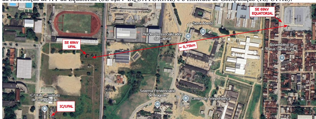
Figura 1 – Vista superior da UFAL A.C. Simões com destaque para a subestação de AT inativa (SE 69kV UFAL), da subestação de AT da Equatorial (SE 69kV EQUATORIAL) e o Instituto de Computação (IC/UFAL).
