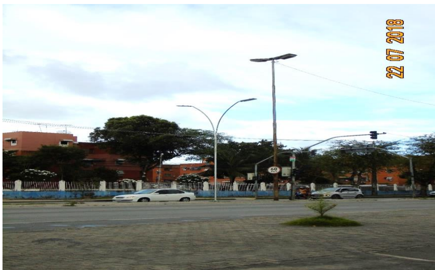
Figura 3 – Avenida Recife durante a mudança das luminárias com lâmpada descarga elétrica para LED.
