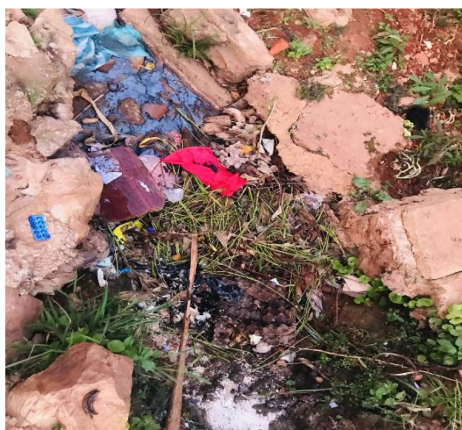
Figura 4: a estrutura de betão interrompida/abandonada e a água parada ou acumulada ao redor
