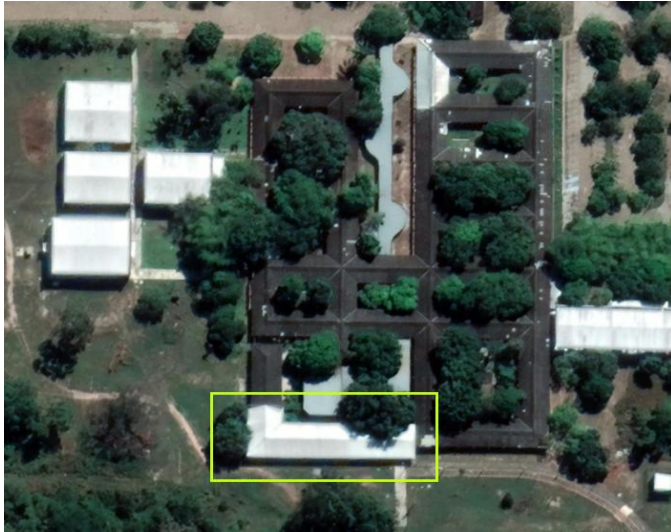
Figura 1: Localização da obra analisada.
