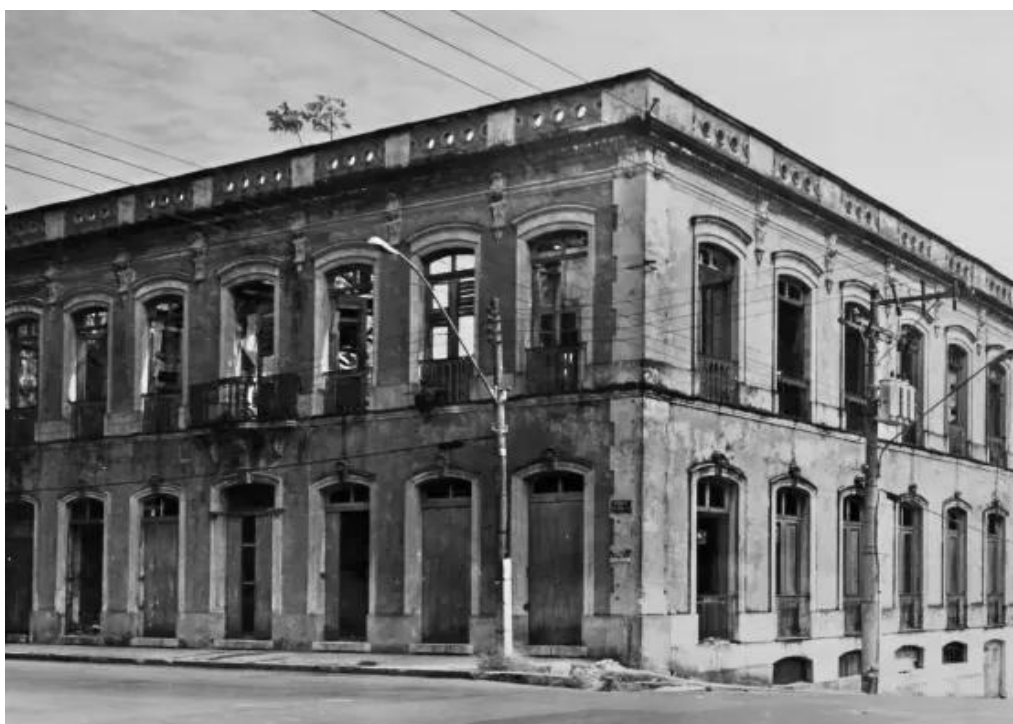
Figura 4. Ruínas do Hotel Cassina.
