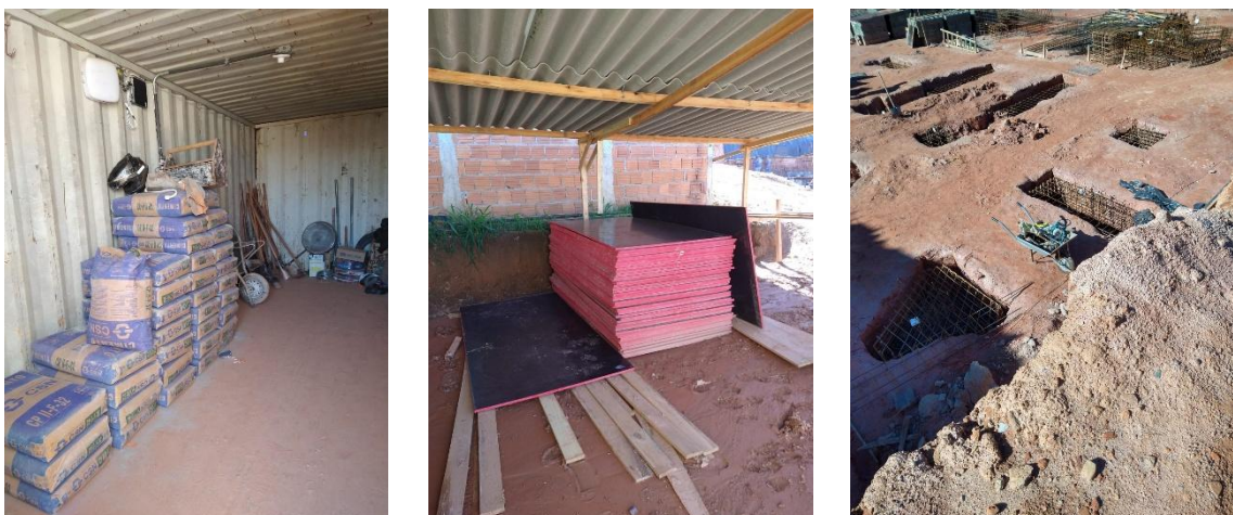
Figura 3 – Canteiros de obras visitados pelos discentes do curso de Engenharia Civil
