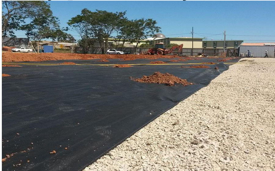
Figura 4 - Assentamento da manta geotêxtil
