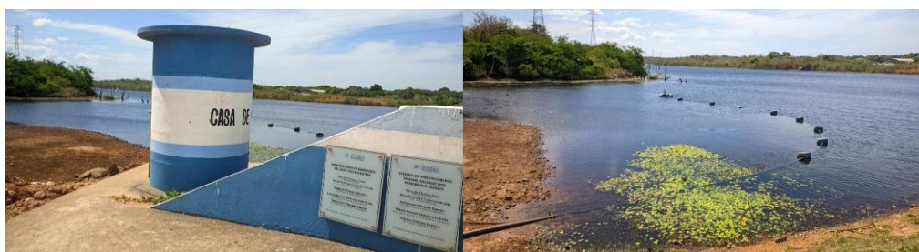
Figura 4- Sistema de captação de água no açude Joaquim Moreira
