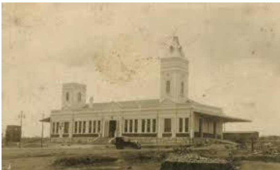
Figura 1- Estação Ferroviária como Terminal
