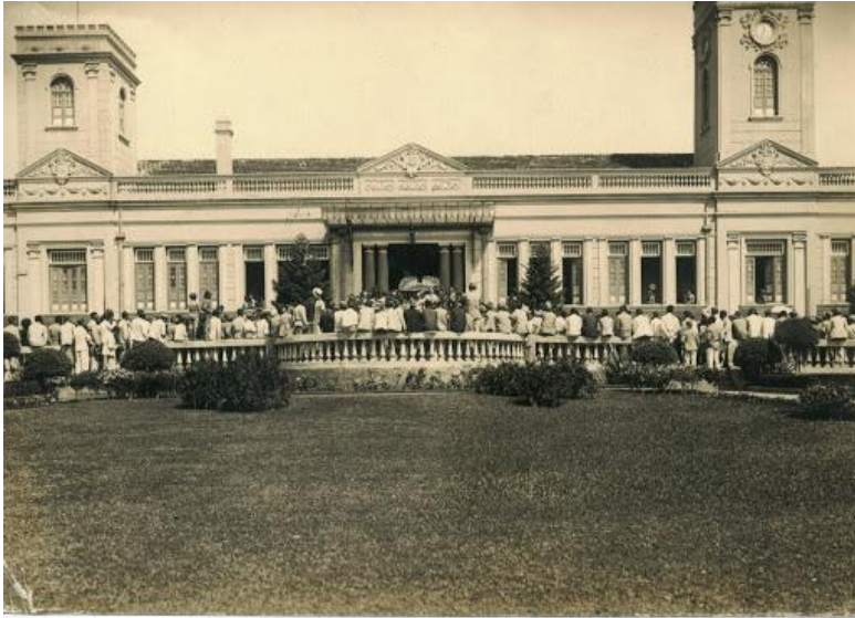
Figura 2- Estação Ferroviária desativada, Museu Dona Beja
