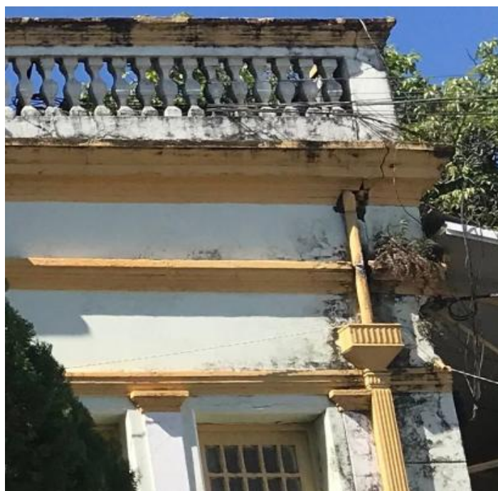
Figura 11 – Exemplos de manifestações patológicas observadas nas fachadas: vegetação de pequeno porte, destacamento de argamassa e manchas superficiais.
