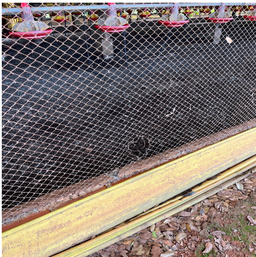
Figura 2 - Tela antipássaros na lateral do galpão danificada por terceiros na hora do carregamento dos frangos para o abate. Ponto que favorece a entrada de aves não desejáveis.
