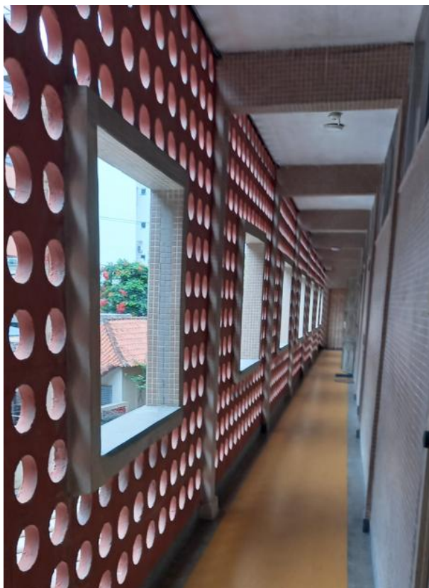
Figura 15 (esquerda): Vista de um dos corredores e hall de escada ventilados, em um dos pavimentos tipo.
