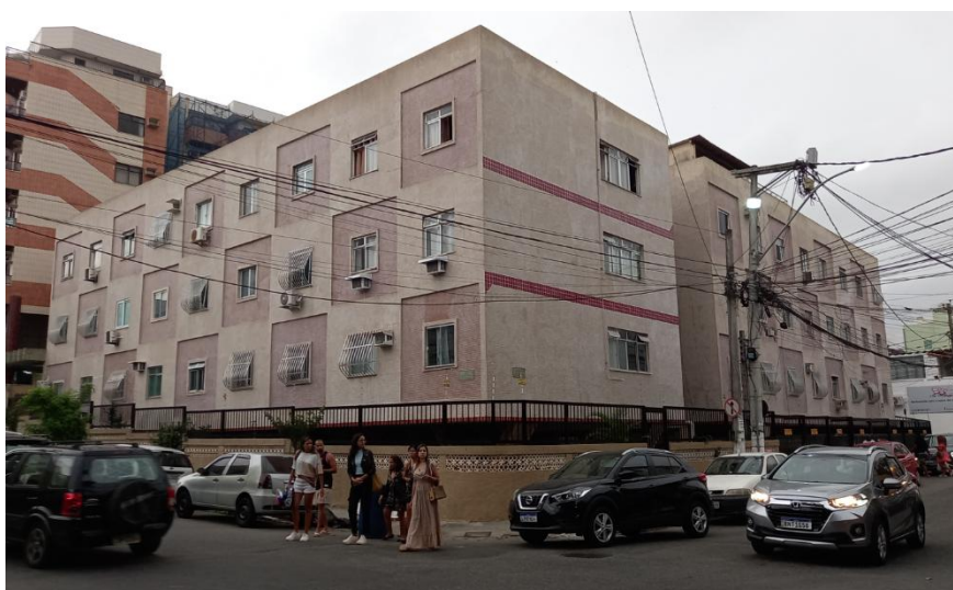
Figura 20: Fachadas voltadas à rua (comparável à Figura 12 e Figura 14). Muros impedem a visualização do pilotis, cobogós tapados e novos revestimentos impedem a percepção do dinamismo do desenho inicial. Fonte: Ivo Barreto, 2025.
