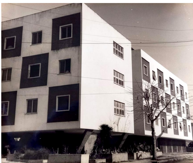
Figura 14 (esquerda): Vista da Fachada principal, com Bloco 2 concluído. No pilotis, jardineiras e sob o Bloco 2 (concluído), portas das garagens, substituindo os jardins fronteiros previstos em projeto.
