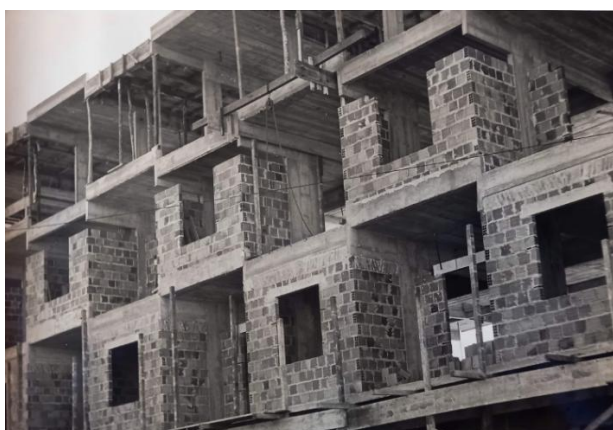
Figura 17: Bloco 1 em fase de execução dos fechamentos em alvenaria (1959), compondo o sistema de módulos de mesma proporção, em paramentos cheios e vazios, solução obtida através da utilização de vigas invertidas sobre as varandas.
