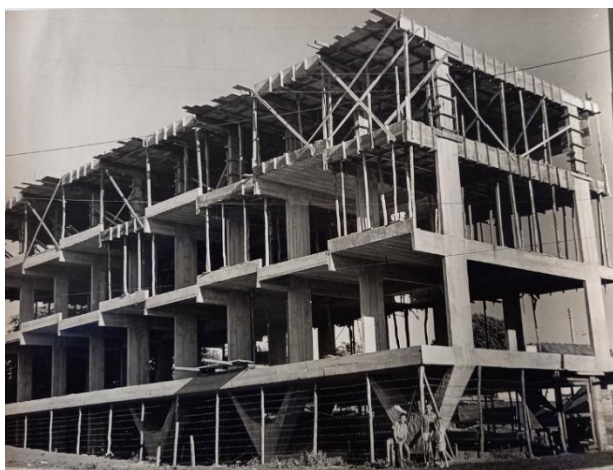
Figura 16: Estrutura do Bloco 1 em fase final de execução (1959): linha interna de pilares recuada, coincidindo com os apoios sobre os pilares, liberando a livre composição da fachada; vigas superiores dos trechos de varanda executadas invertidas (sobre a laje).
