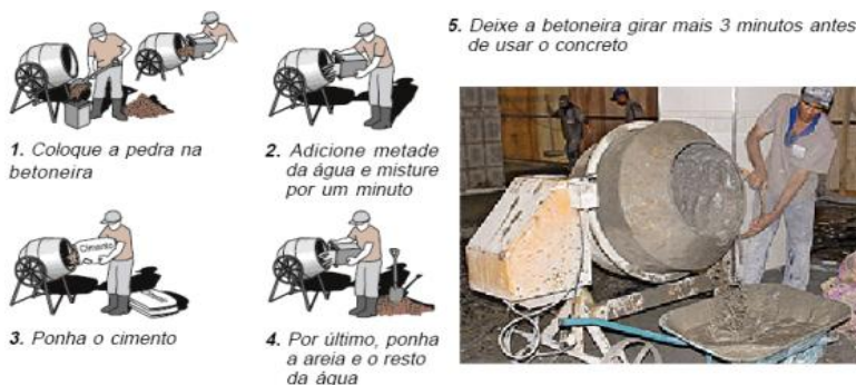
Figura 5 – Preparo do concreto em betoneira.
