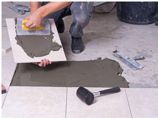
Figura 3 – Assentamento de piso cerâmico.
