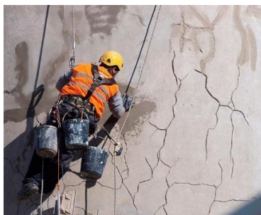
Figura 2 – Fissuras por retração na argamassa.
