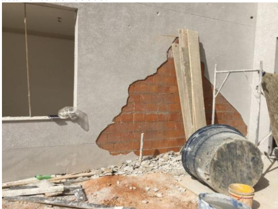
Figura 7 – Deslocamento de reboco.
