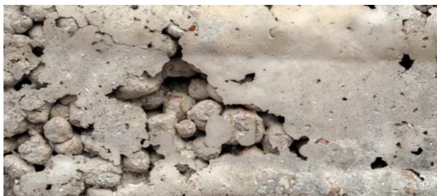
Figura 1 – Dosagem incorreta do concreto.
