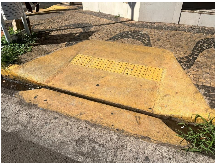
Figura 2 – Rampa de acesso.
