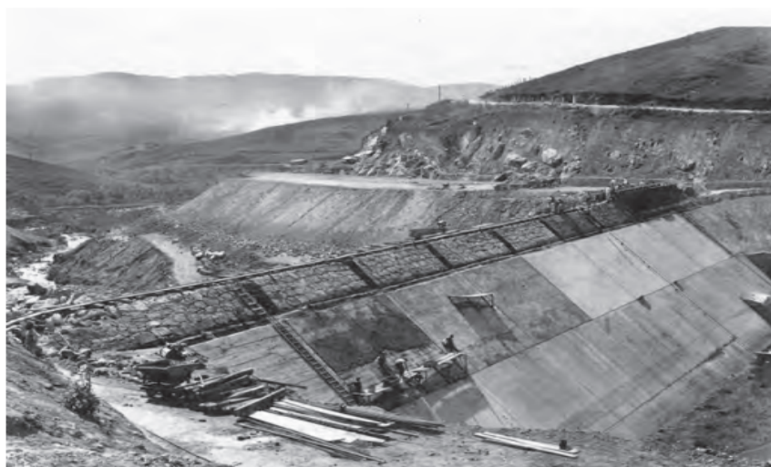
Figura 1 - Barragem Santurnino de Brito, 1933.
