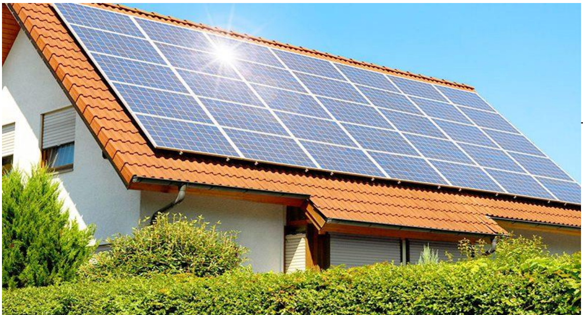
Figura 7: Telhado com placas fotovoltaicas (Boreal Solar, 2016).
