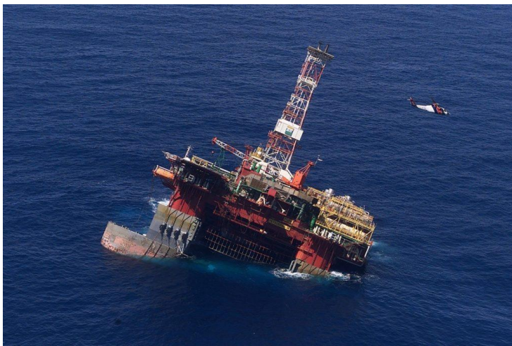
Figura 19: Plataforma Petrobrás - P-36 adernando - Bacia de Campos - RJ. Credito de Imagem: Estado de São Paulo 189
