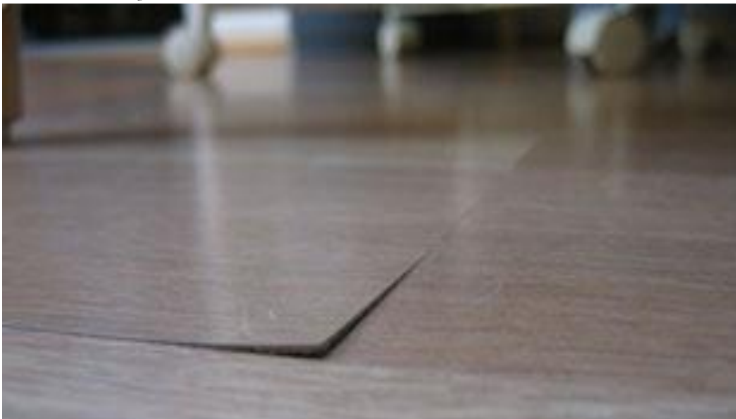
Foto 2: Infiltração na Laje
