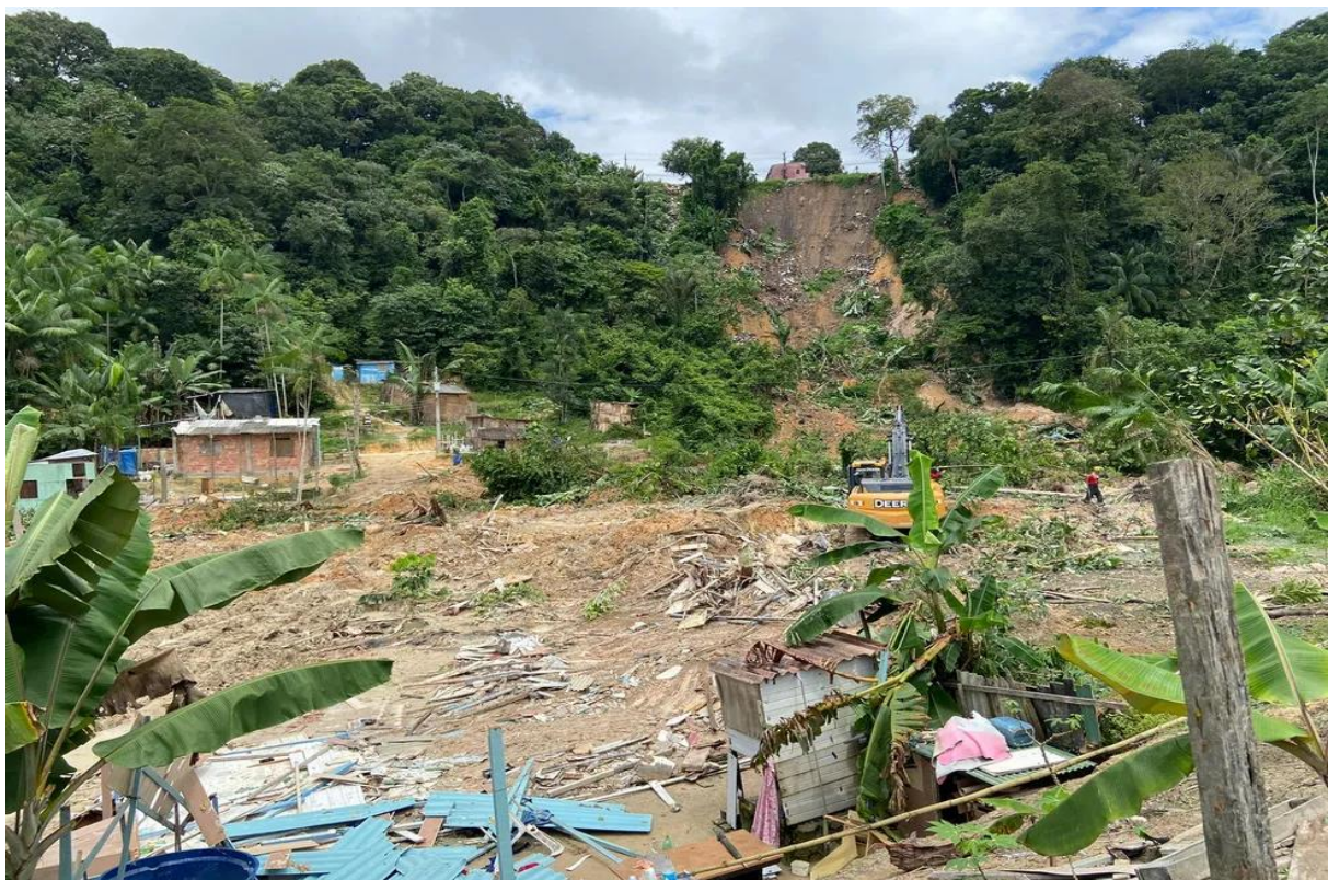
Imagem 1 - Área atingida pelo deslizamento
