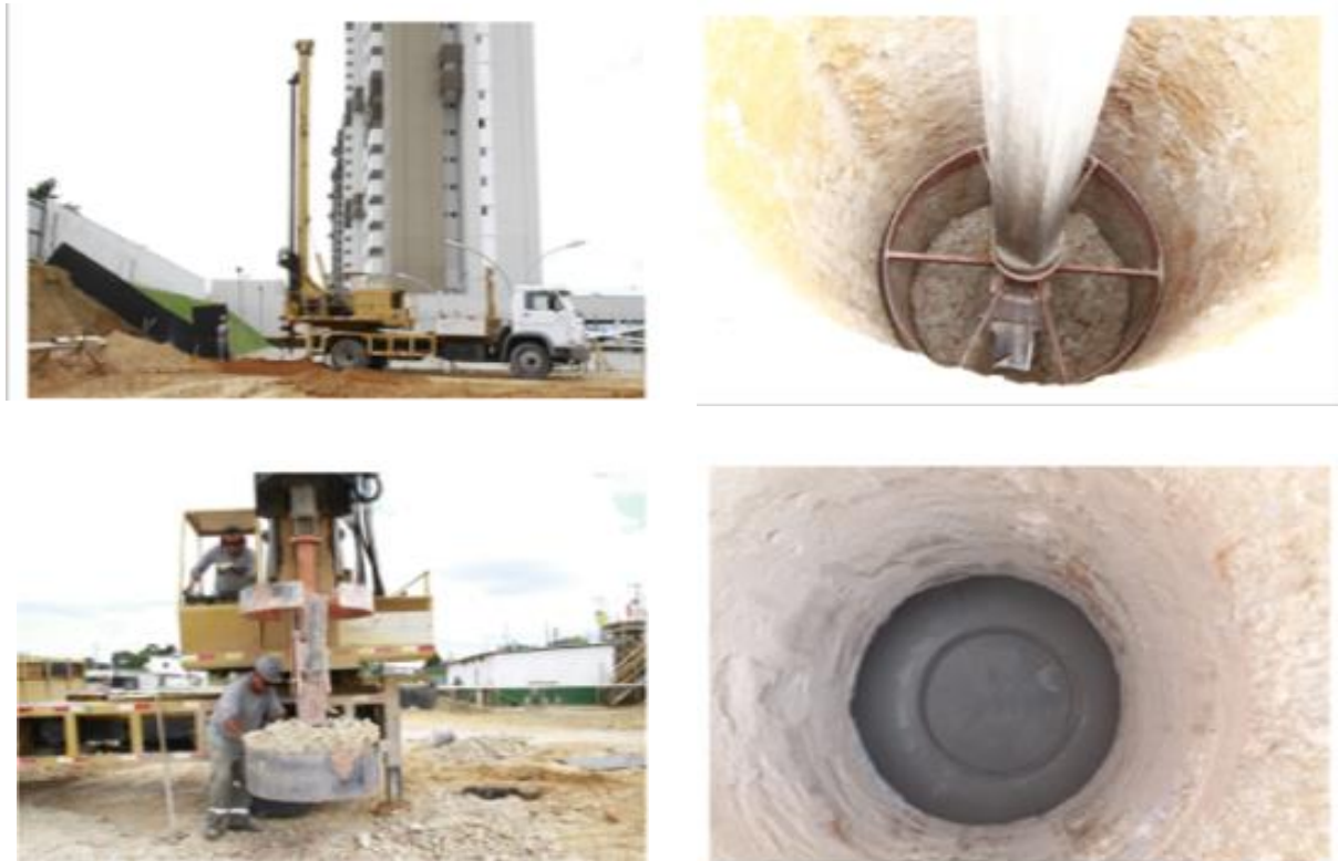
Figura 1-Processo de escavação e alargamento de base do fuste
