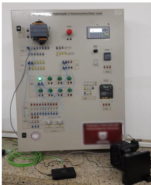
Figura 5- Conexão entre CLP, IHM e Switch
