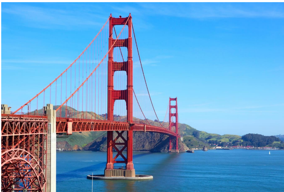
Figura 26 - Ponte Golden Gate, EUA (1935)
