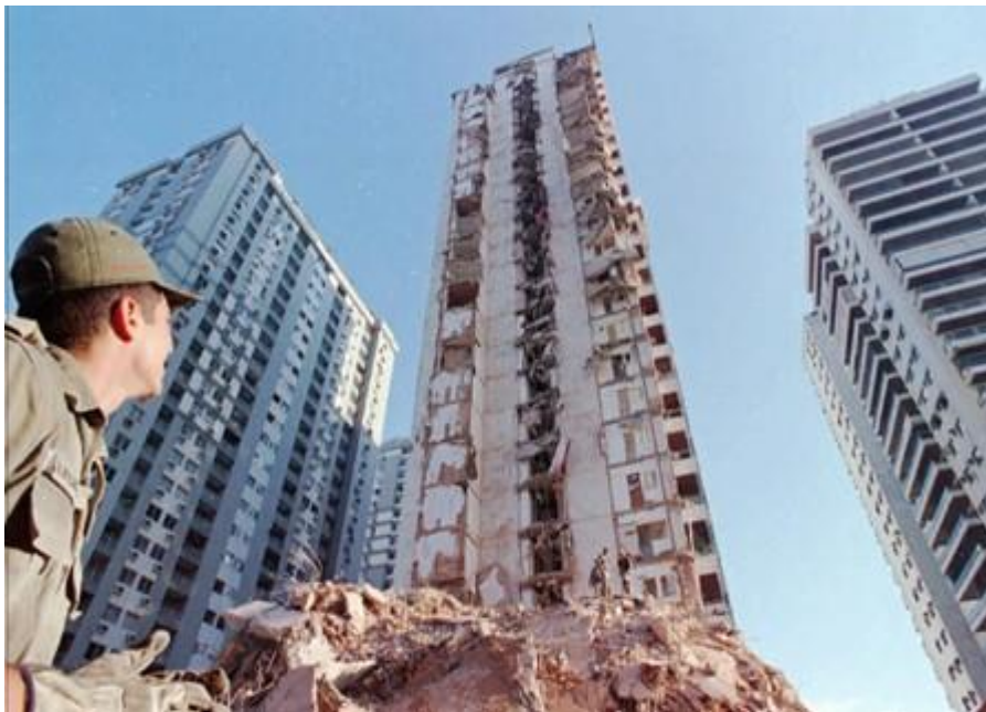
Figura 20 – Prédio Palace II
