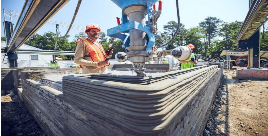
Figura 31 – Impressão 3D na Construção Civil
