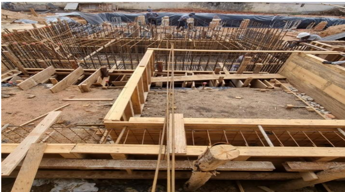
Figura 4- Preparação para concretagem de dispositivos de fundação.
