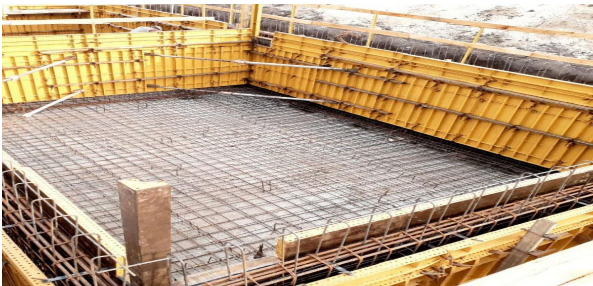
Figura 7- Armaduras de aço envoltas de formas metálicas prontas para concretagem.
