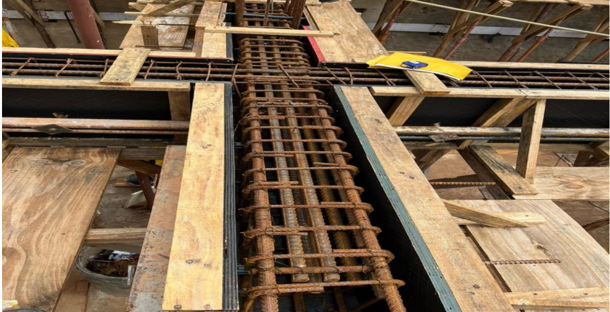
Figura 6- Armadura de aço das vigas envoltas de formas de madeira prontas para concretagem.
