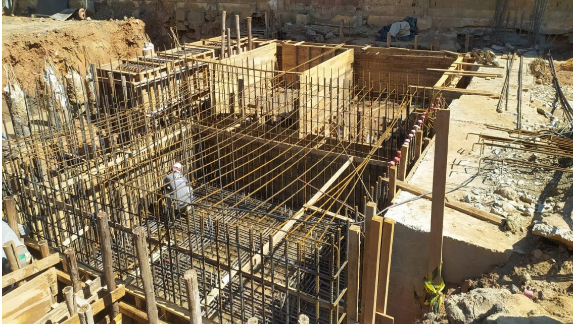
Figura 3- Armaduras de aço envolvidas com formas de madeira convencionais para concretagem.
