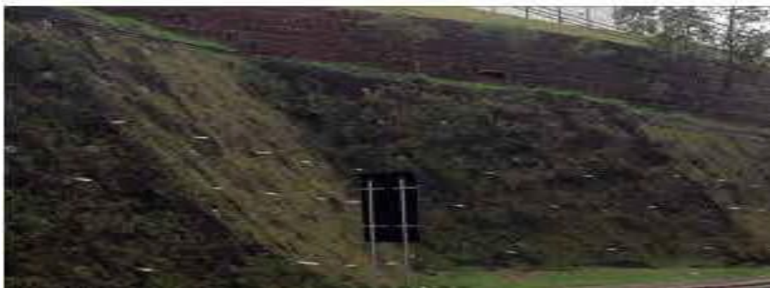
Figura 2: recuperação do talude com solo grampeado
