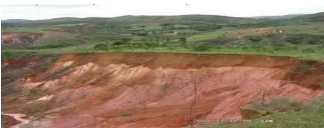
Figura 1: Imagem de ruptura de talude por escoamento
