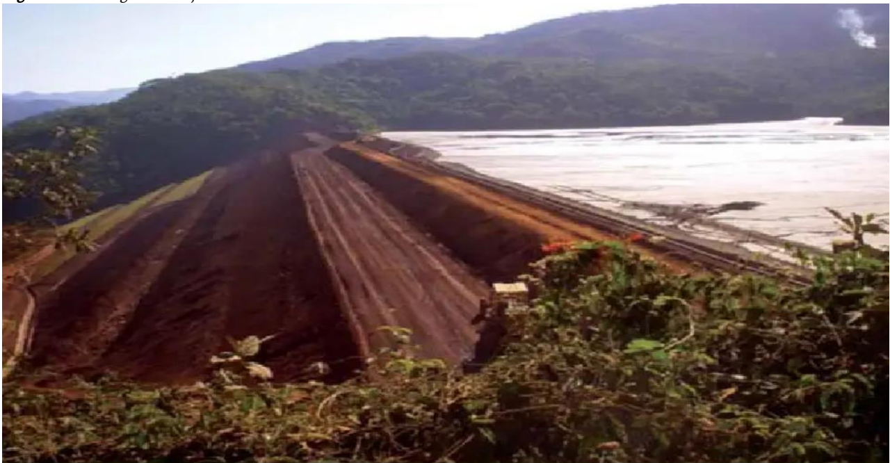
Figura 01 – Barragem de Rejeito
