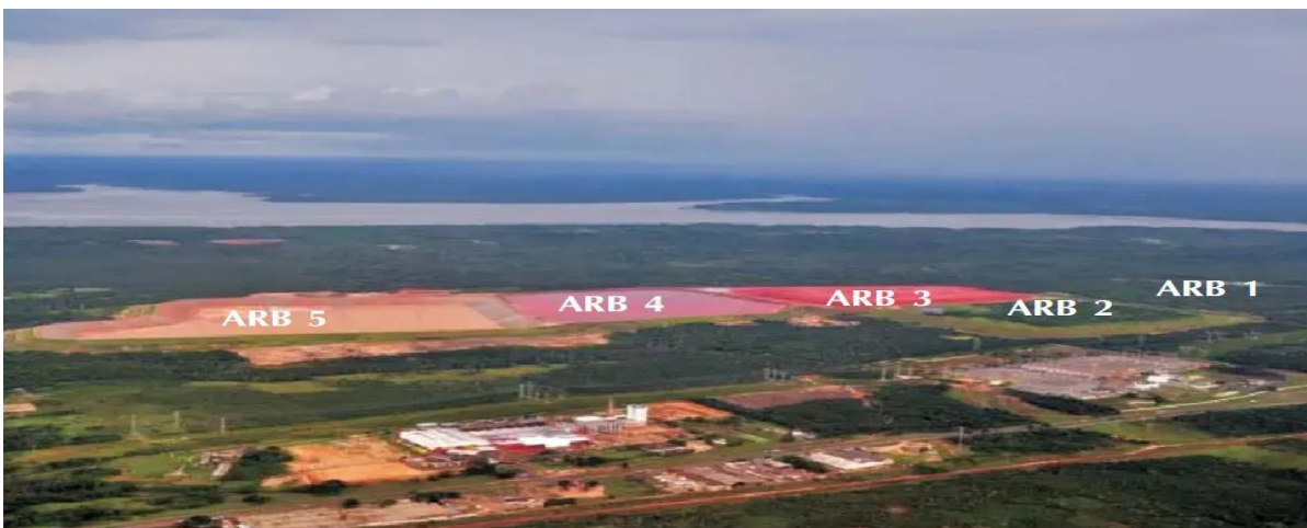
Figura 04 – Barragem de Rejeito
