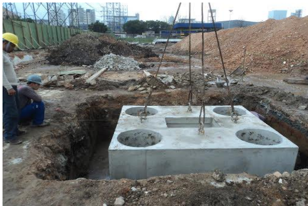
Figura 7. Blocos de fundações pré-moldados
