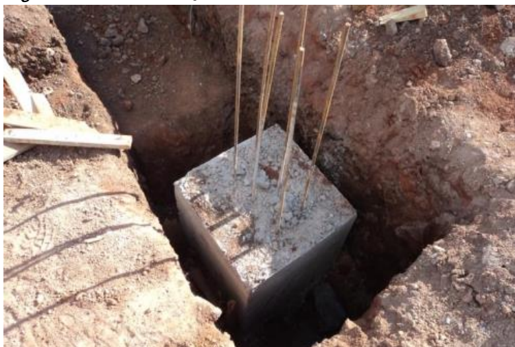
Figura 6. Bloco de fundação
