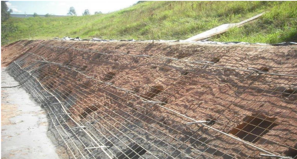
Figura 3 - Grampos instalados e alojados para a injeção
