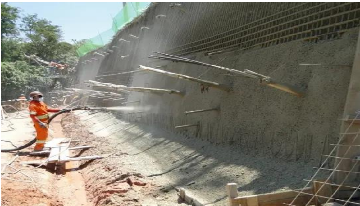
Figura 4 - Revestimento Concreto projetado
