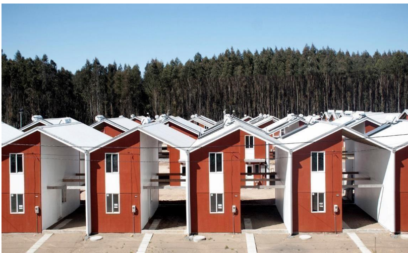
Figura 7 – Fachada do Projeto Villa Verde 2016
